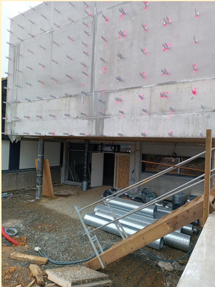
Façade nord – entrée rue des écoles
